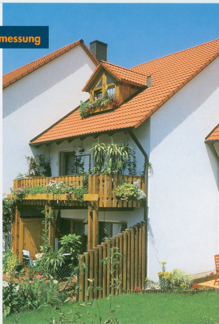
Ein erfolgreicher Test, d.h. es werden keine undichten Stellen in der Gebäudehülle gefunden. Ein Beweis für die Bauqualität.
